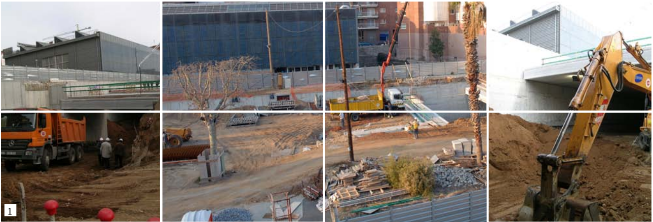
1- FOTOGRAFIA DE LES OBRES DE L'APARCAMENT DE LA PLAÇA OCCITÀNIA
