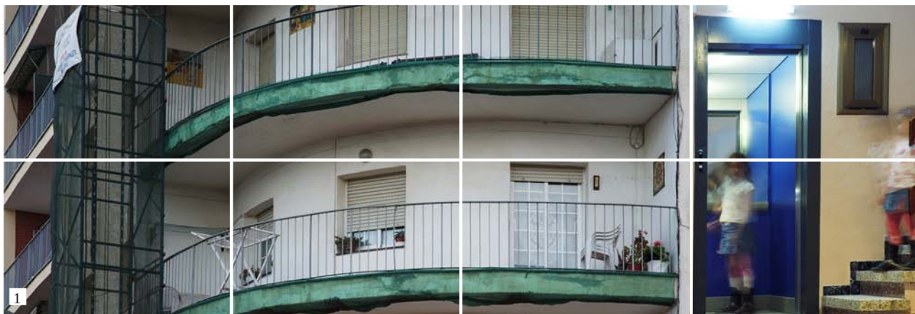
1-FOTOGRAFIA DE LES OBRES DE REHABILITACIÓ DE L'EDIFICI DE LA RONDA DE JOAN D'ÀUSTRIA
