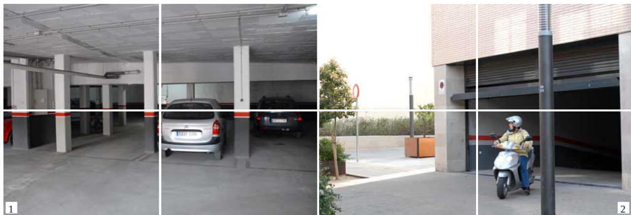
1- FOTOGRAFIA DE L'INTERIOR DE L'APARCAMENT DE SOLÍS 2- FOTOGRAFIA DE DE L'APARCAMENT DE CARRER COLÓN
