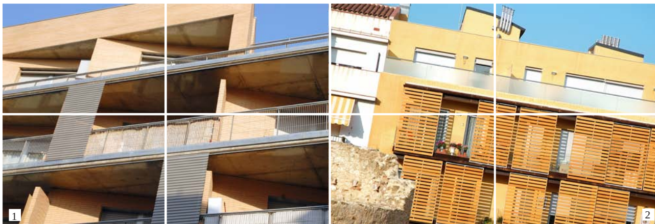
1- FOTOGRAFIA DEL HABITATGES DEL CARRER VALÈNCIA 2- FOTOGRAFIA DEL HABITATGES DEL CARRER HOSPITAL
