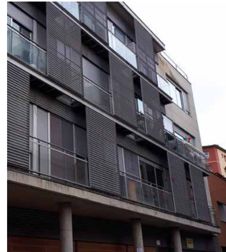
▲ Cal destacar l’edifici del carrer Núñez y Balboa, destinat a persones amb mobilitat reduïda.
