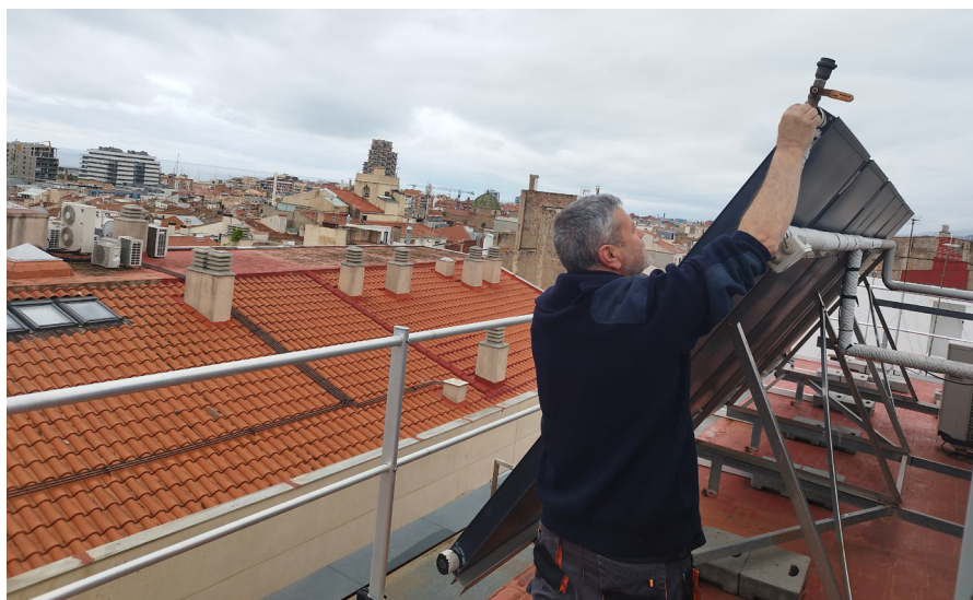
TASQUES DE MANTENIMENT A UN HABITATGE
