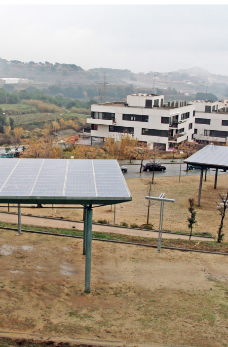
FOTOVOLTAIQUES DE VALLVERIC
